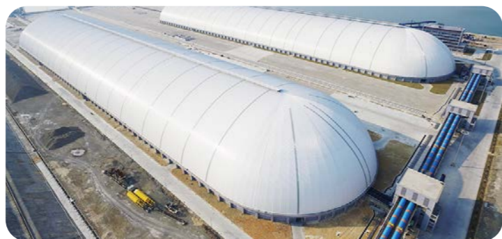
▲ 惠州港荃湾港区煤炭码头一期岸电建设工程
